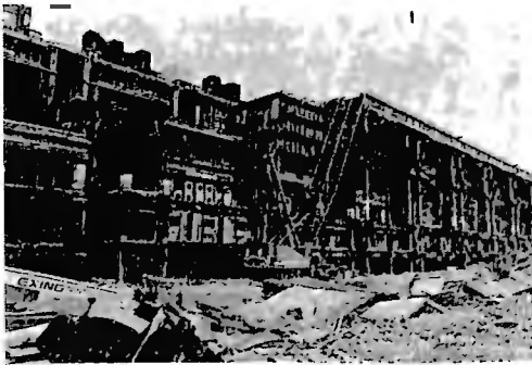
図-5 解体工事中の尼一(昭和62年3月)
