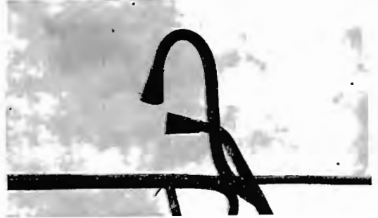
図一四 尼二・本館屋上の伝声管(昭和62年1月)
